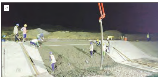
Рис. 8. Укладка бетона в канале: a – подготовительный бетонный слой на откосах; b – панель на дне канала; c – панель на откосе канала Fig. 8. Concrete placements at the JEC-FMC: a – blinding layer in the sloped side; b – a panel in the base slab; c – a panel at a sloped side
