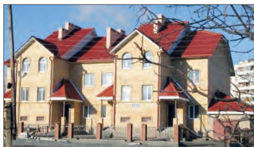
Малозэтажный дом с асбестоцементными листами и трубами в опалубке и с заливкой внутри легким пенобетоном Low-rise house with asbestos cement sheets and pipes in the formwork and with filling inside with light foam concrete
