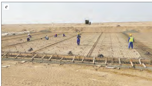
Рис. 6. Плита дна канала, армированная решеткой из стеклопластиковых стержней: a – поставка стержней; b – хранение стержней на подготовительном бетонном слое внутренней панели дна канала (в подготовительном слое видны отверстия для последующей установки дренажных труб); c – первичное размещение стержней; d – сборка сетки; e – окончательная подготовка сетки из стержней и опалубка для устройства продольного шва
