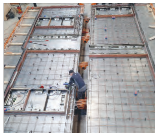
Опалубка «Бабочка» в развернутом положении – горизонтальная подготовка "Butterfly" formwork in the unfolded position – horizontal preparation
